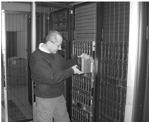
Fig.3 - Sistemista CILEA all'opera durante l'installazione
