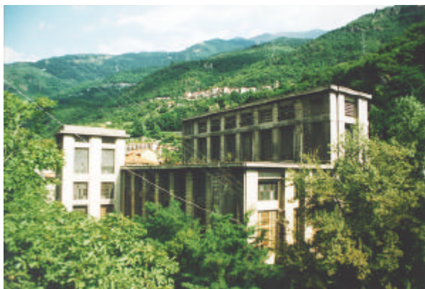
Fig. 5 - L'ex Centrale idroelettrica dell'Enel a Cedegolo (Valle Camonica, Brescia).
